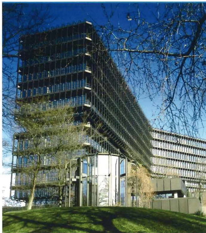
Europäisches Patentamt – Isargebäude München. Foto: EPA
